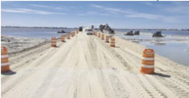
Para a população em geral a ponte será reaberta em 21 de outubro.
