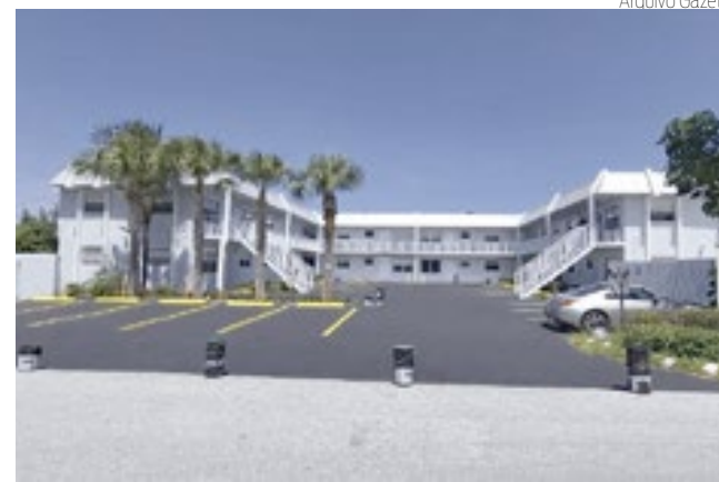
Fachada de prédio reformada pela GCS - General Services
